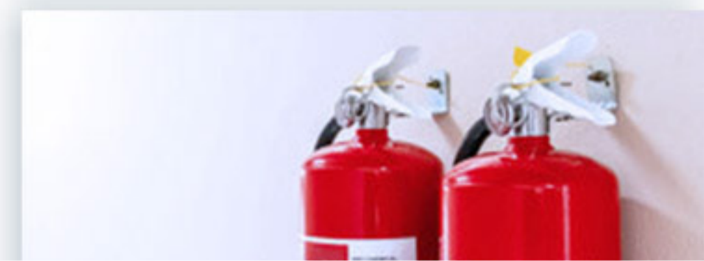
EXTINTORES Y ALARMAS
